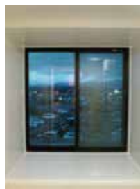
施工後の出窓
