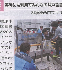
「みんなの井戸」2号機竣工
