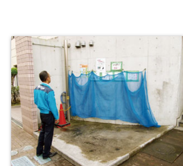
巡回点検 外壁点検、電気設備等点検、 ゴミ置き場等の清掃確認、 駐輪場・放置自転車等の点検
