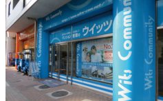
エス・プラザビル
